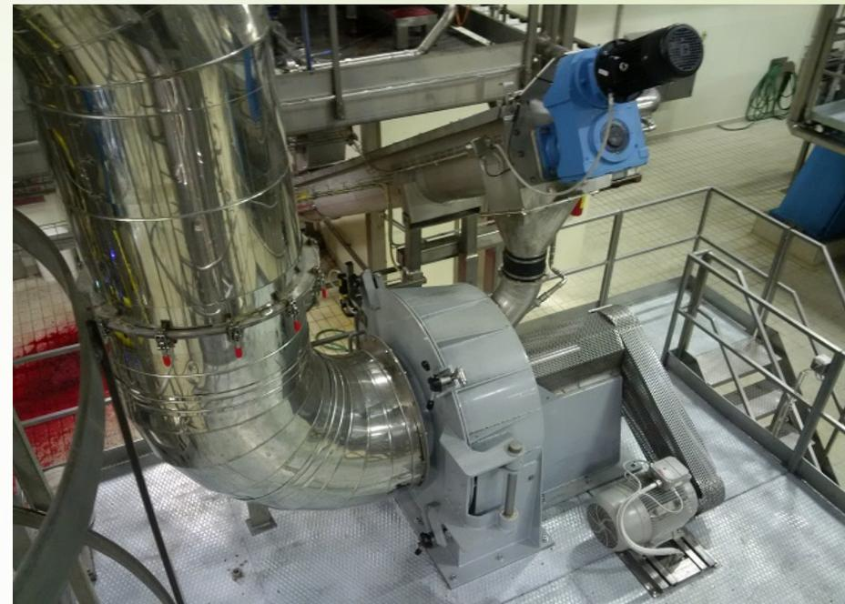
Кольцевая сушилka для твердых и полутвердых отходов
